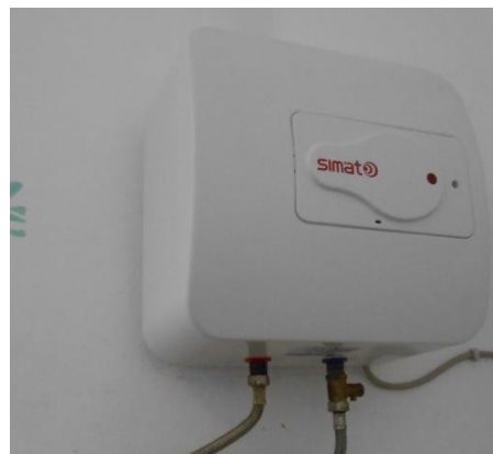
Figura 4.11 - Particolare di un boiler elettrico
