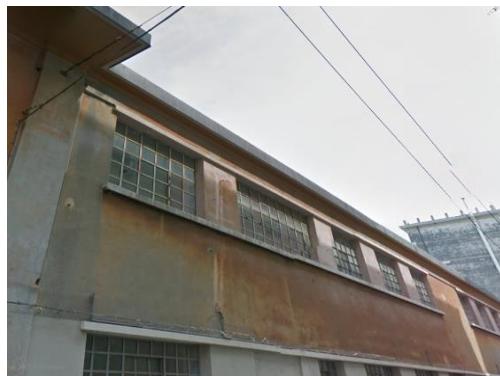
Figura 4.1 - Particolare della porzione di involucro lato NW
