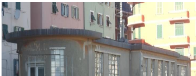
Figura 8.1 – Particolare copertura piana
