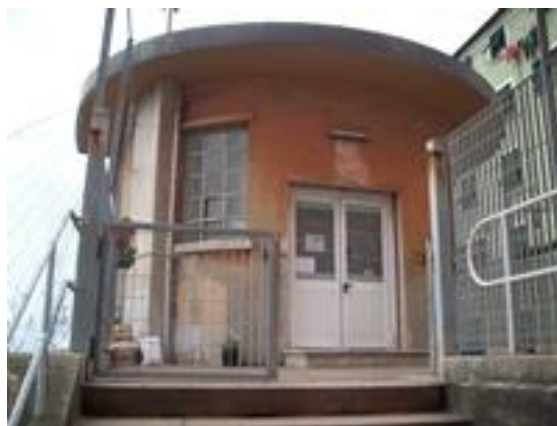
Figura 1.1 - Vista della facciata esposta a Nord-Ovest
